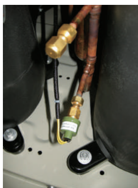
Реле высокого давления
