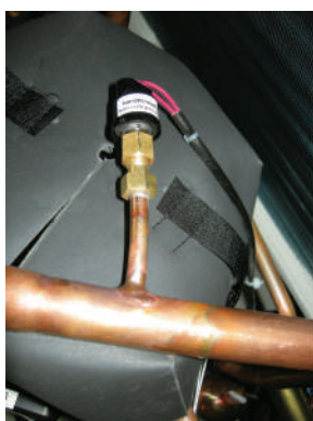
Реле низкого давления
