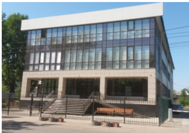
КОЛ-ЦЕНТР «ТЕЛЕ2» Иркутск, 300 квТ
