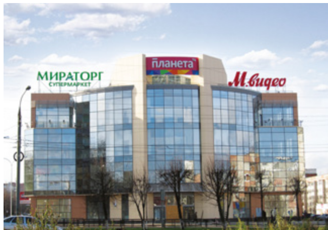
ТОРГОВЫЙ ЦЕНТР «ПЛАНЕТА» Йошкар-Ола, 836 квТ
