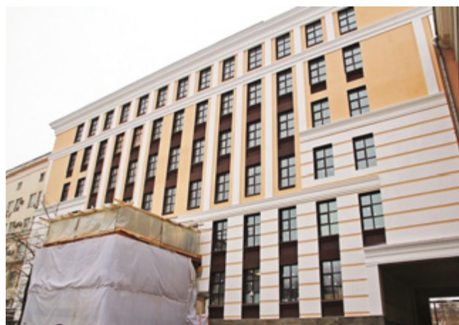
БИЗНЕС-ЦЕНТР «БАСМАННЫЙ ПАРК» Москва, 495 кВт
