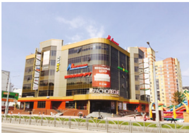
ТОРГОВЫЙ ЦЕНТР «КРАСНОЛЕСЬЕ» Екатеринбург, 700 квТ
