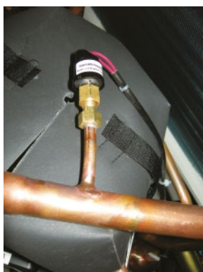
Реле низкого давления
