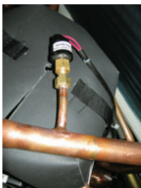
Предохранительный клапан низкого давления
